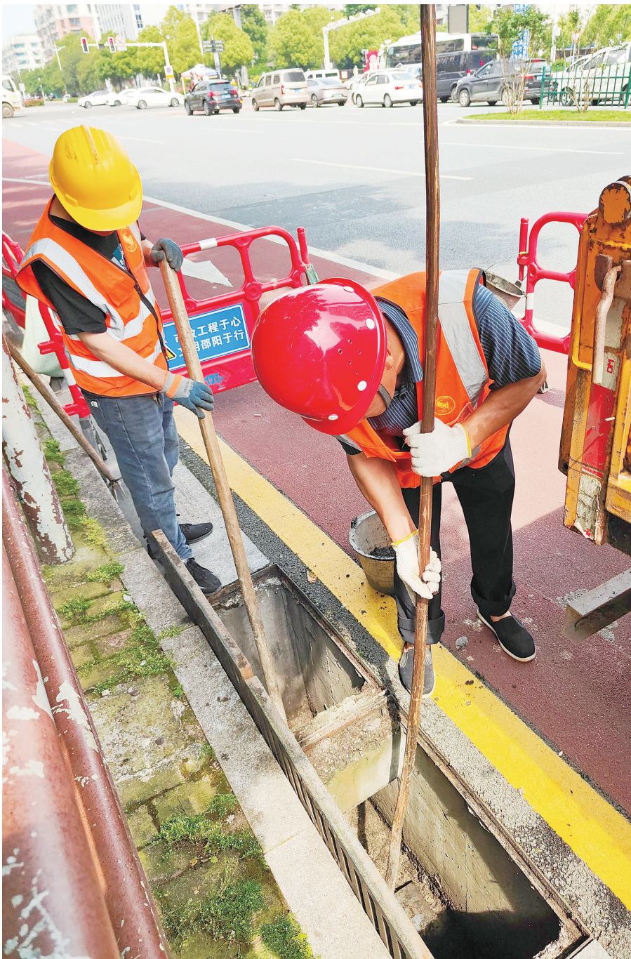
市政维护人员使用工具,清掏雨水篦子底部的淤泥、落叶、杂物。
