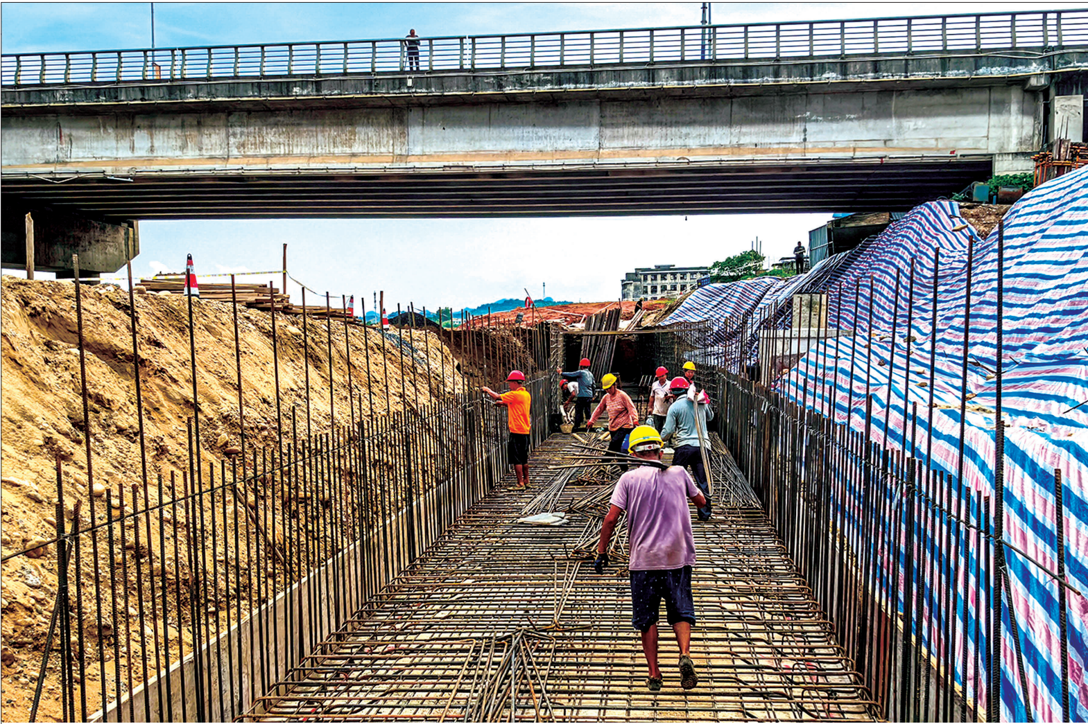
5月23日,新宁县城城区夫夷江湘水大桥下,施工人员进行排水渠收尾,力争尽快完工,确保安全度汛。 郑国华 摄
