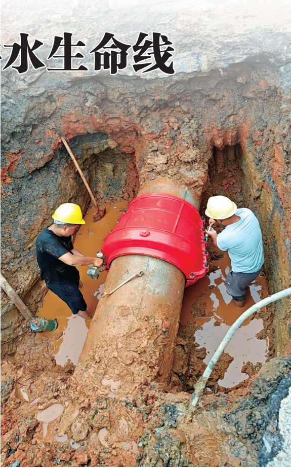
▲市自来水公司工作人员抢修突发爆裂的供水主管道。
