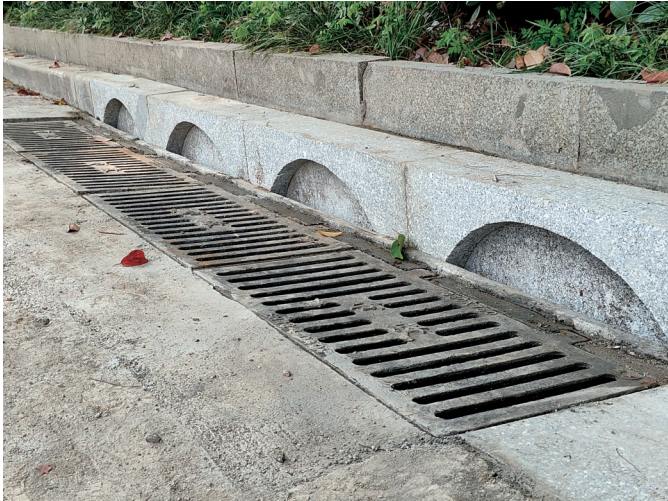
▲改造后的雨水算子增加了侧立面排水功能。
