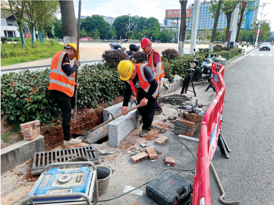
▲市市政维护事务中心工作人员在邵州路魏源广场路段对雨水算子进行“整形”改造。
