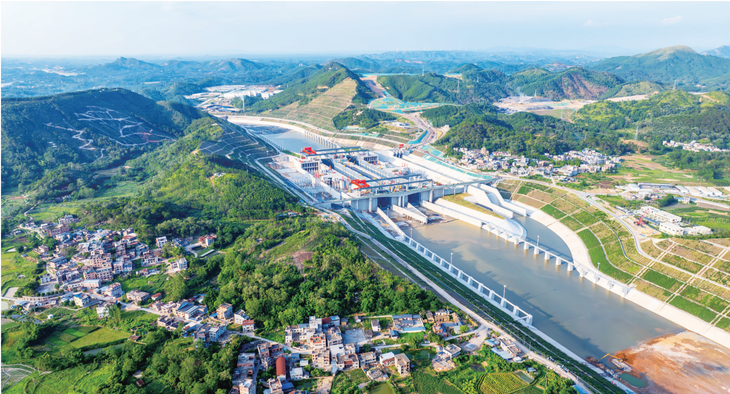
图为6月3日拍摄的广西平陆运河马道枢纽充水现场(无人机照片)。 新华社发(赵振宇摄)
