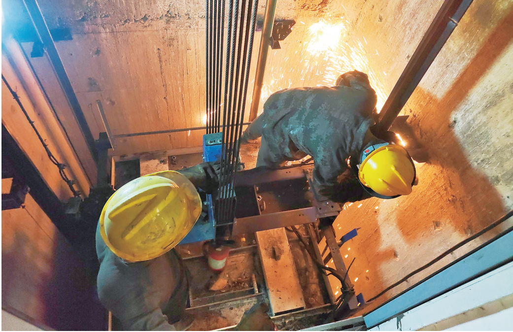
施工人员正在对老旧电梯导轨进行切割拆除。
