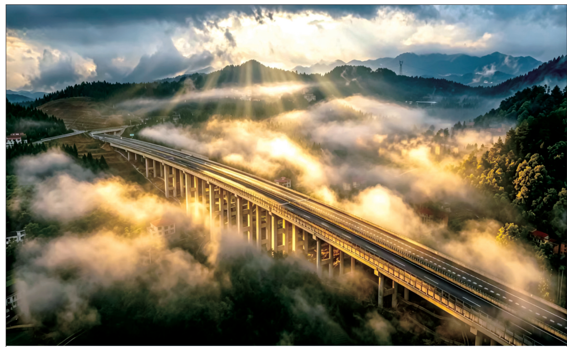
6月7日清晨，新新高速公路隆回县荷香桥段晨光穿云、云雾缭绕，高架桥如银龙游弋山间，呈现壮美景象。 阳自田 摄
