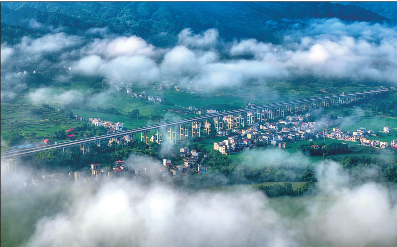
6月15日,雨后初晴的洞兴高速岚山段云雾缭绕,高架桥穿云而过,构成一幅流动的山水画卷。作为连接湘桂的重要通道,该高速自通车运营以来,彻底改变了沿线山区“出行难、发展慢”的局面,将交通优势转化为经济动能,有力撬动了岚山旅游及周边乡村产业发展,成为名副其实的振兴路、富民路。 朱巨滨 摄
