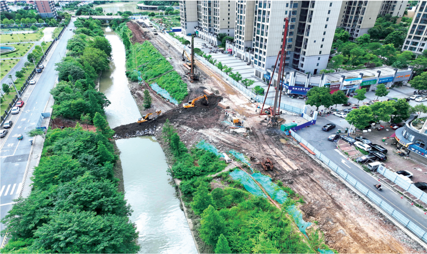
红旗河路与红旗河步行桥改造工程施工现场。
