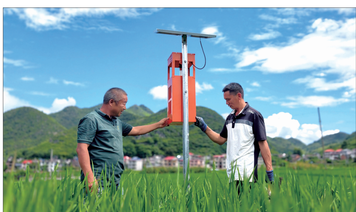
7月9日,城步苗族自治县儒林镇田塘村,工人正在检查太阳能杀虫灯的安装情况。今年,该县规划在儒林、西岩、茅坪、丹口等乡镇基本农田内安装太阳能杀虫灯905盏,以减少各类病虫对农作物的危害,确保粮食稳产增产。预计本月底可全面完成杀虫灯的安装。 严钦龙 摄
