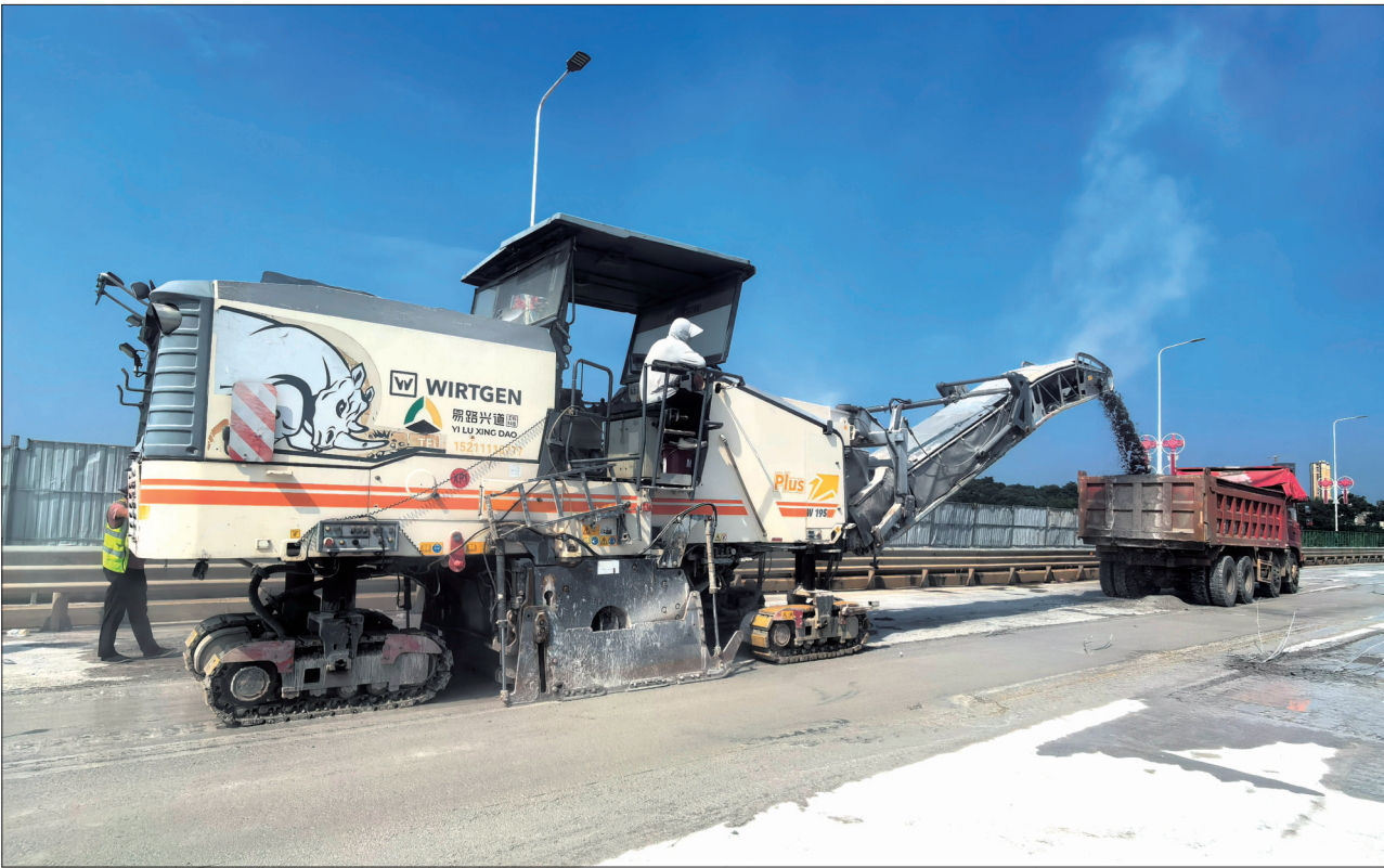
7月13日,市区资江二桥正式开始全封闭维修施工。此次维修施工内容包括桥面翻新铺装、桥梁主体结构加固、道路交通配套改造三个方面,维修工期预计约半个月。图为施工人员操控铣刨机进行铣刨路面作业。 邵阳日报记者 伍洁 摄
