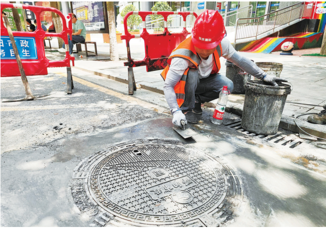
施工人员均匀摊铺混凝土,保证井盖与路面齐平。
