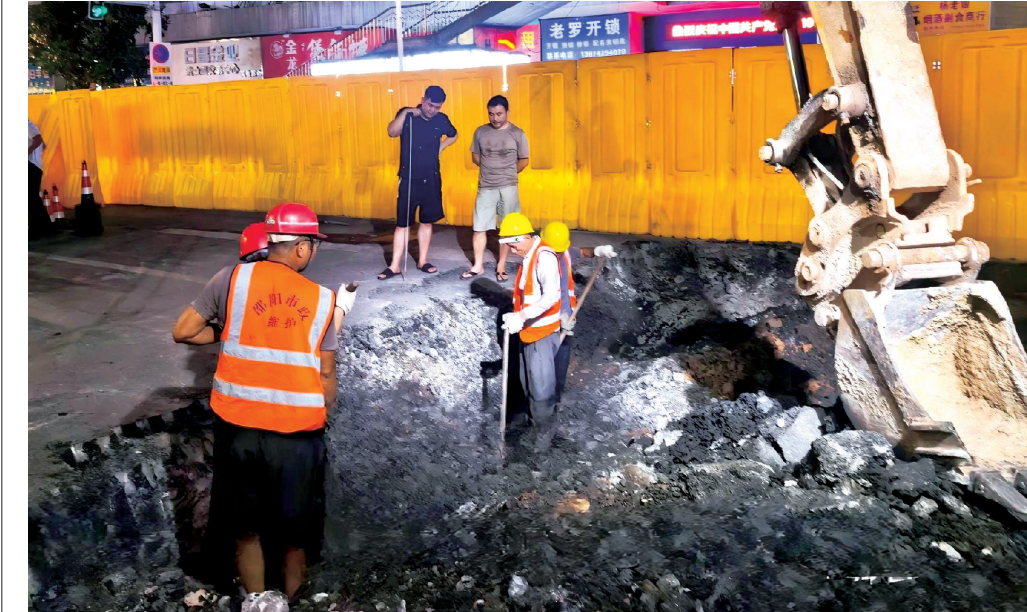
施工人员连夜抢修。
