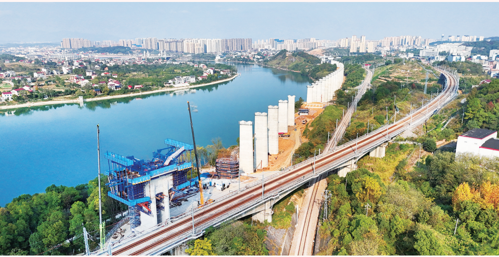
施工中的邵永高铁。
