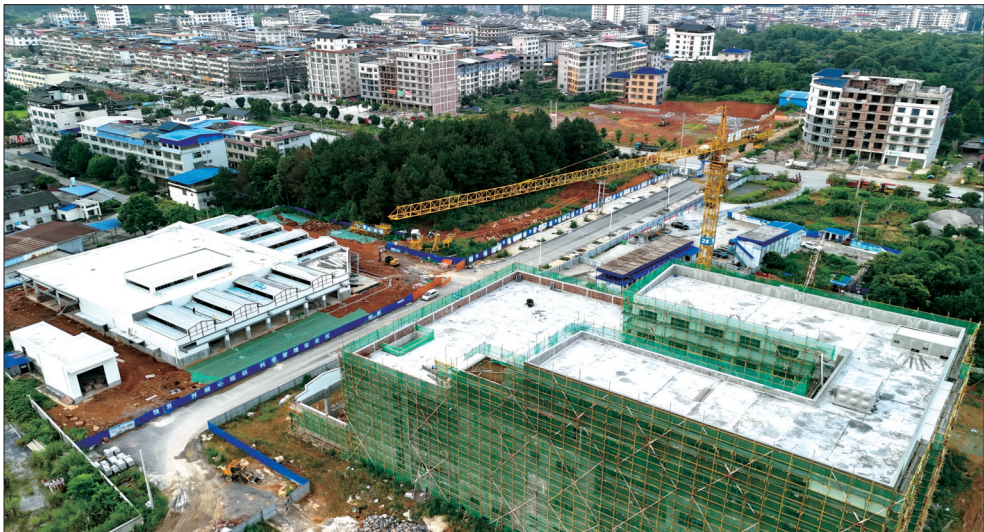
7月27日清晨,建设中的城步苗族自治县城北农副产品冷链物流交易市场一期项目。该项目占地1万余平方米,总投资5600多万元,预计今年9月底竣工。项目建成后,将极大提升农副产品流通效率,延伸农业产业链条,推动当地乡村振兴。
