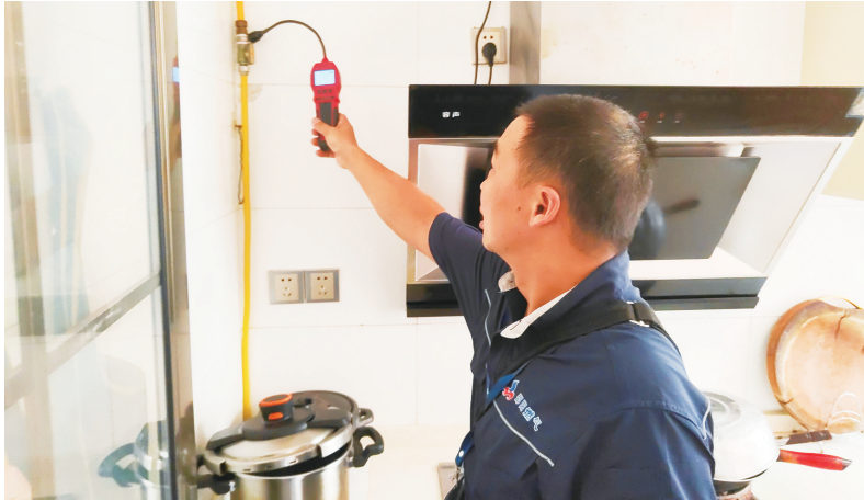
工作人员走进居民家中,开展燃气安全检查。
