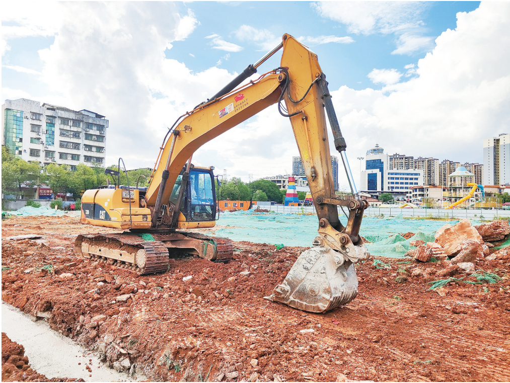
挖掘开展土地平整作业。
