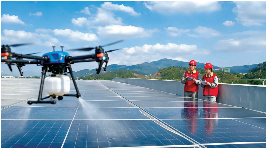
电力运维人员在邵阳富士电梯光伏电站开展光伏组件清洁作业。
