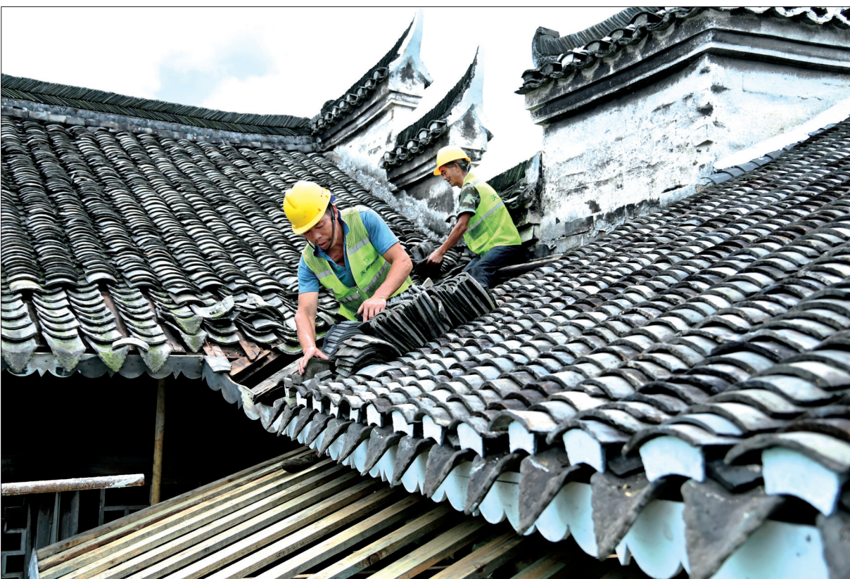
8月3日，施工人员在绥宁县李熙桥镇陈家村对古建筑进行修缮。近年来，该县按照“修旧如旧、整体保护、合理利用、延续文脉”原则，加大对古街、古巷、古宅等历史名胜古迹保护性修缮力度，让古建筑焕发新活力。 滕治中 黄开龙 摄影报道
