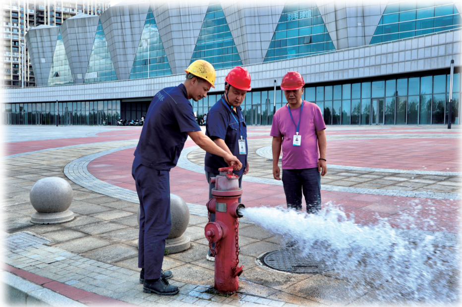
市自来水公司员工对场馆外圈的市政消防栓进行通水试压。
