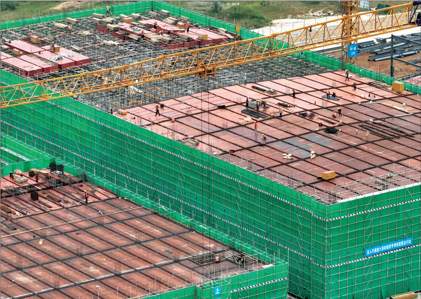
8月17日,洞口县花古街道经冠智能科技产业园项目建设工地,工人们在进行施工作业。针对连日来的持续高温天气,该县各重大项目建设工地采取错峰作业模式,避开正午高温时段,落实防暑降温措施,在保障工人健康和安全生产的前提下,全力以赴有序推进项目建设进度。 滕治中 滕绍忻 摄影报道
