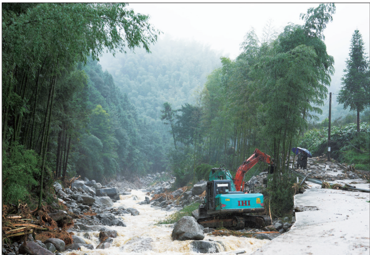
图为9月3日,在炎陵县奎溪乡茶垅村,工程机械在清理碎石和道路淤泥。 新华社记者 陈振海 摄
