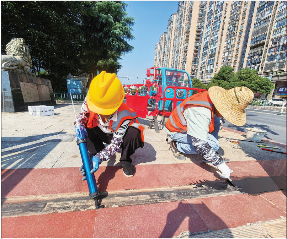
9月8日上午,市政工程总公司城市桥梁管理所的维修人员对余湖桥桥梁上的伸缩缝进行密封胶填充作业,以防桥梁渗水。
