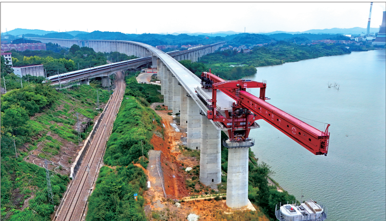
邵永铁路全长约96公里,双线电气化,设计时速350公里。全线通车后,邵阳至永州行程约30分钟。图为9月9日,架桥机在跨沪昆特大桥架梁作业,该桥为邵永铁路全线最长、墩身最高的桥梁。
