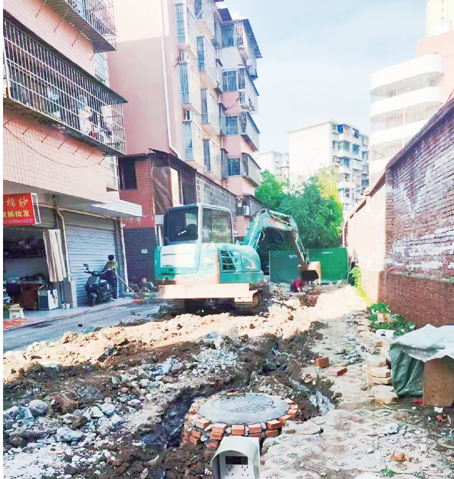
下水管道改造施工现场。
