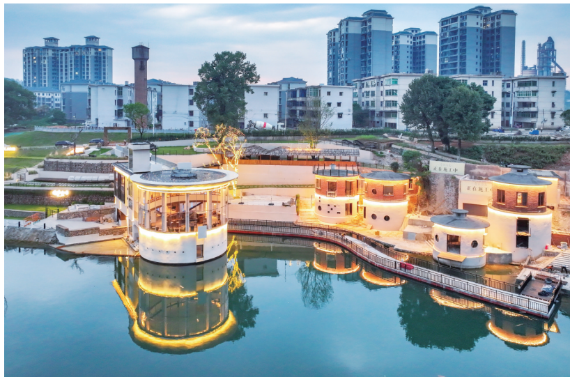
资兴市东江湾，废弃多年的水泵房被改造成倚沙·音乐浮岛艺术剧场。
