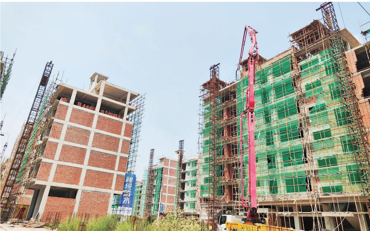
北塔区柘木三期安置房建设现场。
