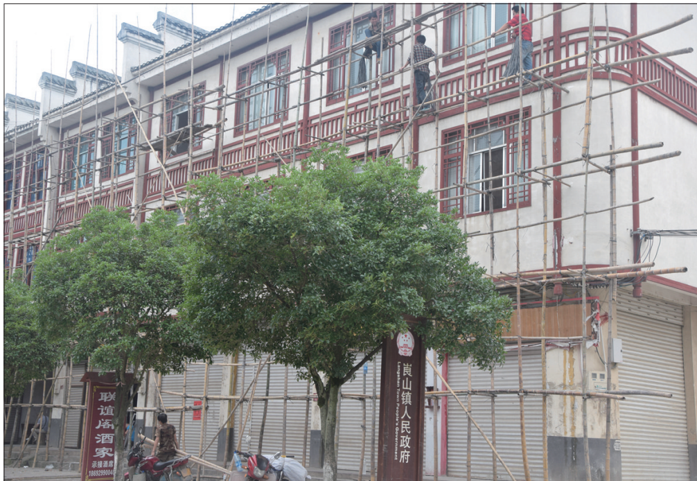
5月30日,新宁县崑山镇窑市街,施工人员正在为房子“洗澡”。该镇为了给游客一个美好的环境,每年清洗一次景区的房子。石国兴 摄
