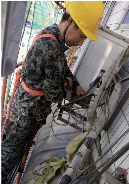
杨勇军正在拆装空调外机
