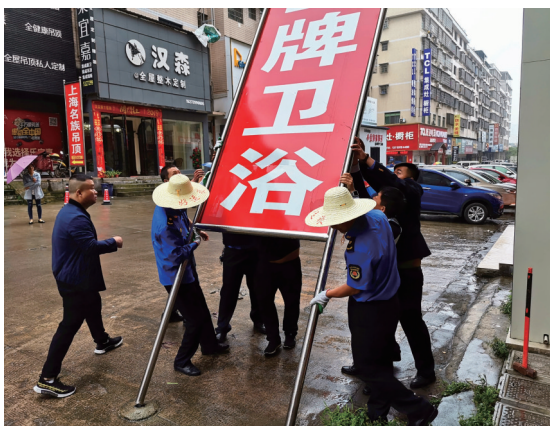
▲工作人员依法拆除违规户外广告牌。
