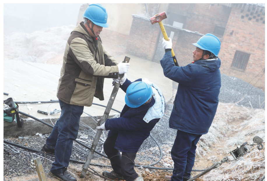
2月19日,国网邵阳供电公司抗冰保电抢修小组成员在龙溪铺镇下源片区卓家村打三联桩,作为临时拉线基础。由于持续低温,该镇冰冻严重,造成部分电力线路因覆冰过重断裂。该公司积极组织抢修队员,奋战在抗冰保电一线,当日共恢复卓笔、后塘等村近200户村民的正常用电。
