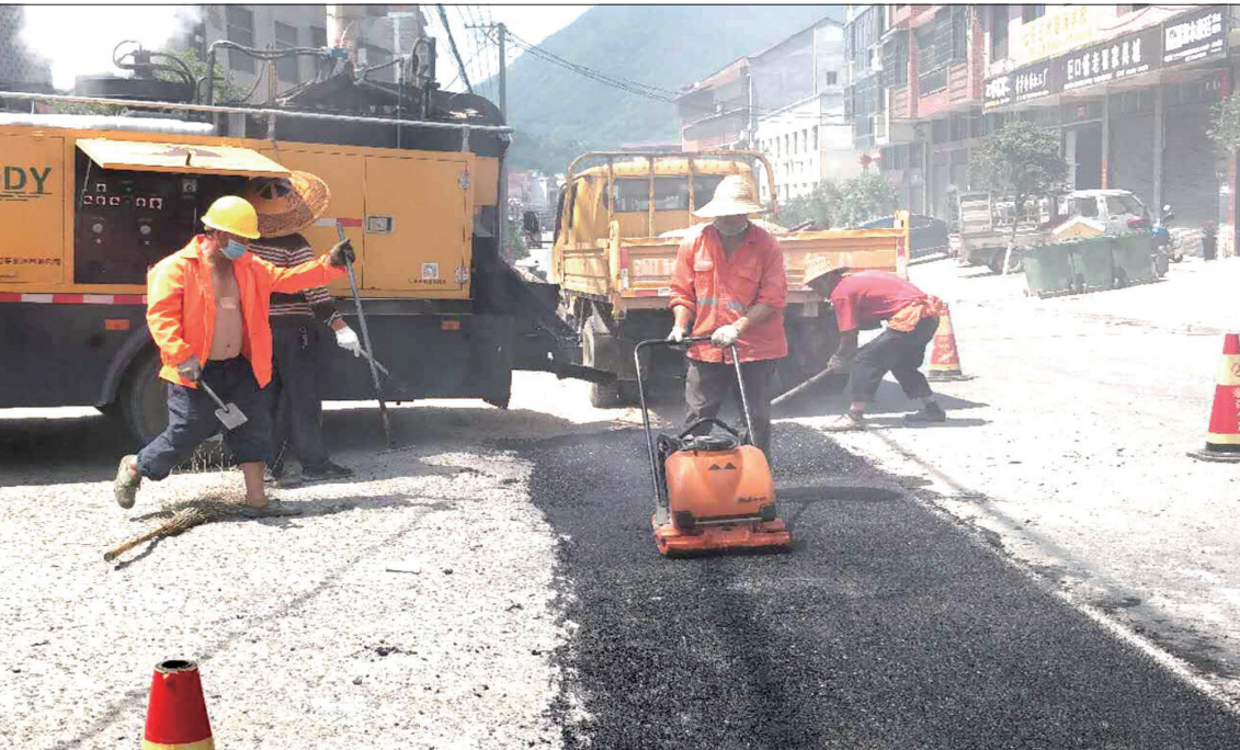
6月4日,在S217线巨口镇镇路段,新邵县公路局养路职工头顶烈日,用温度高达120℃以上的热拌沥青混凝土填补坑槽。 邵阳日报记者 杨敏华 通讯员 何雯 卿海波 摄影报道
