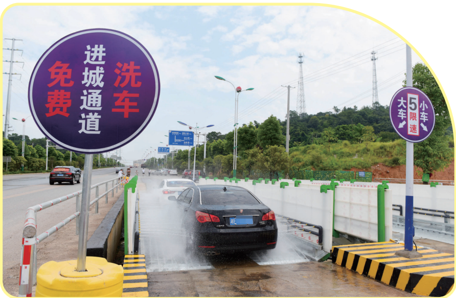
▲大祥区桃花路进城免费洗车系统投入使用,有效缓解车辆带泥进城造成的扬尘污染。邵阳日报记者 申兴刚 摄
