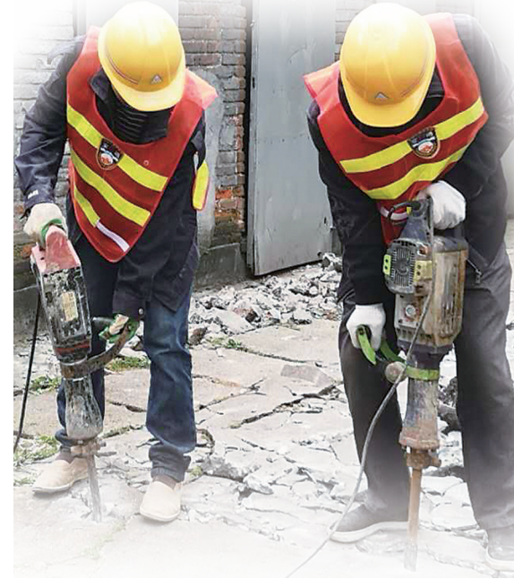
施工人员正在现场作业。
