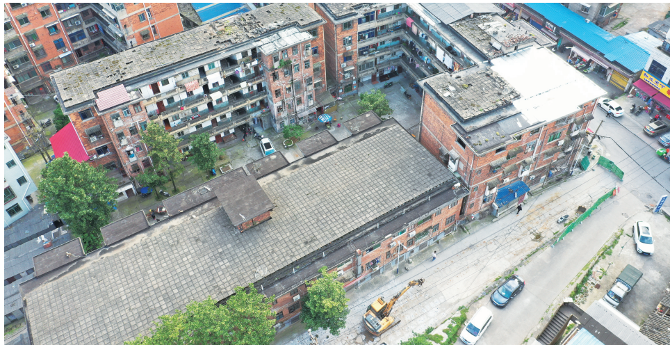
目前已开工改造的塔北社区染料厂小区。
