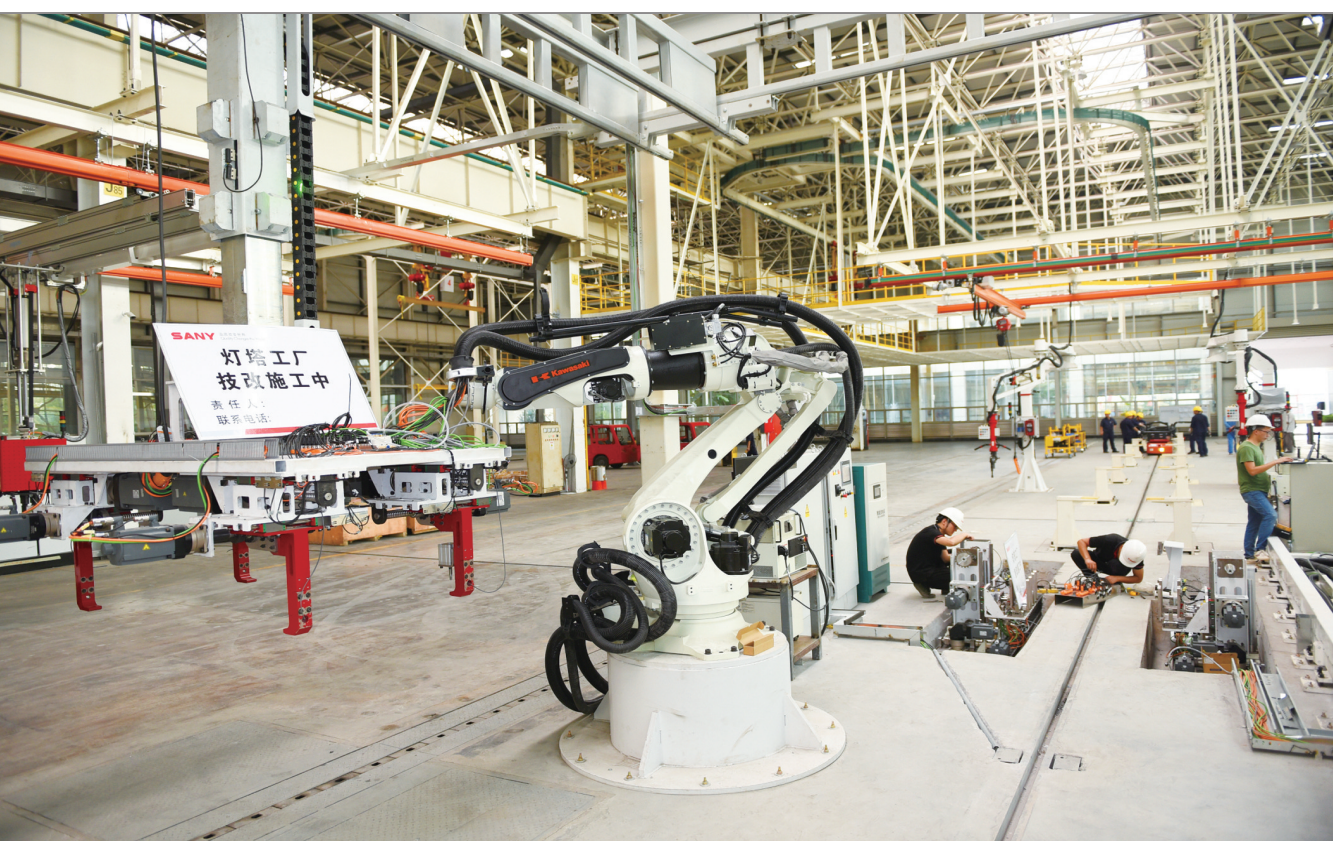
三一专汽灯塔工厂项目按整体规划两期实施的方式推进,总投资约8亿元,规划年产底盘5万台、搅拌车3.3万台、自卸车1.2万台。目前,一期建设稳步推进,计划8月份投产。图为7月15日,正在进行改造施工中的三一专汽灯塔工厂自动化生产线。
